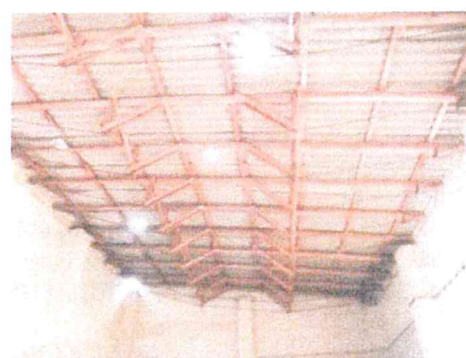
Stavba – interier střecha
