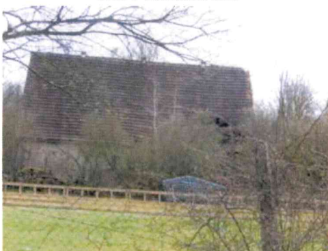
ppč. 12/2 - pohled severní
