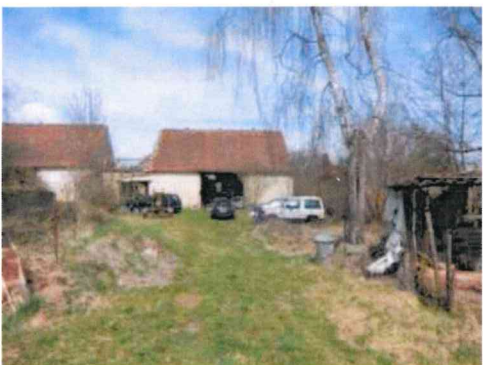
st.34 - jižní pohled
