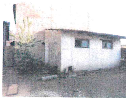
st. 104 a st. 105 – pohled JZ
