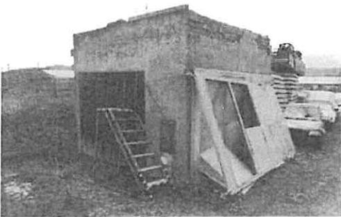
Stavba na St. 1516
