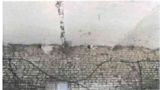
Interiér stavby - spodní podlaží
