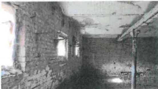
Interiér stavby - spodní podlaží
