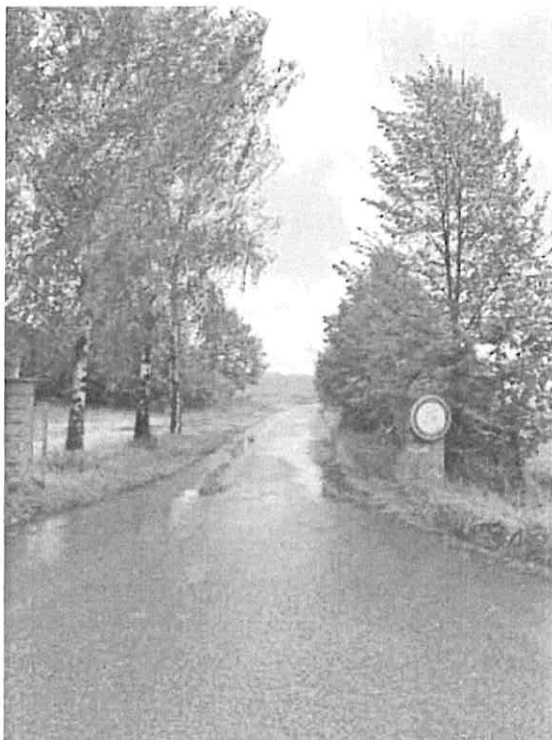
Pozemek parc. č. 3916 - příjezd
