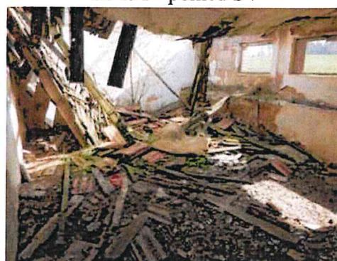
st. 191 - interier-spadlý strop
