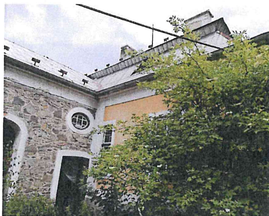
jihozápadní strana domu včetně vstupu do domu ze dvora
