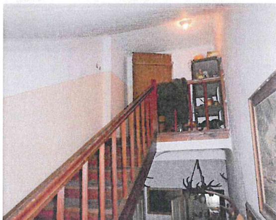
schodiště na půdu
