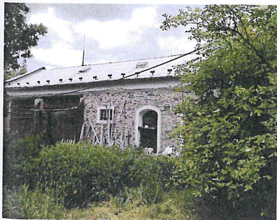
pohled na vedlejší stavbu ze dvora
