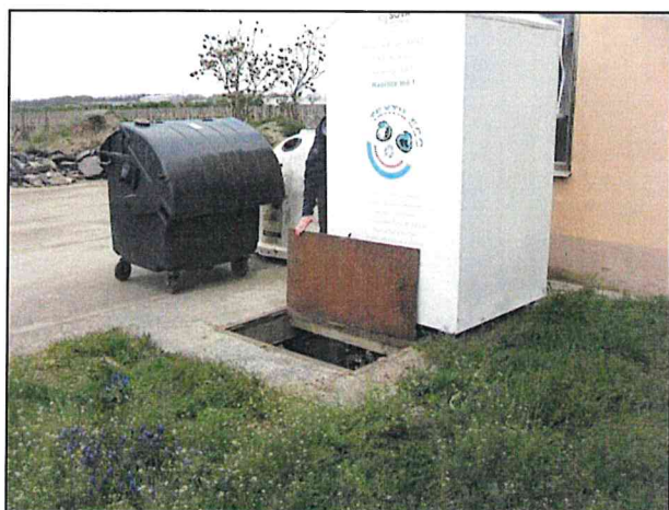
Vstup do montážního prostoru
