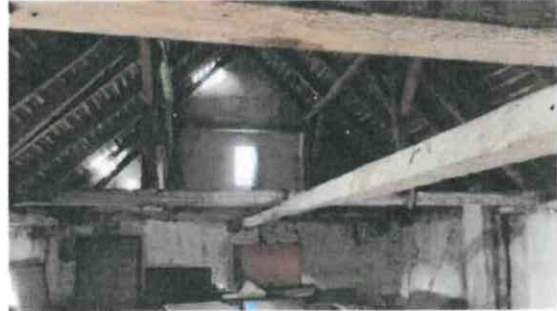
Interiér stavby - nadzemní podlaží
