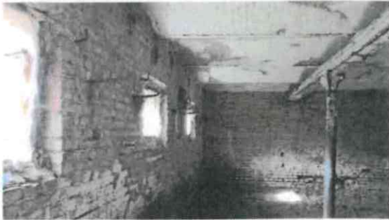
Interiér stavby - spodní podlaží
