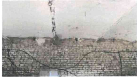
Interiér stavby - spodní podlaží
