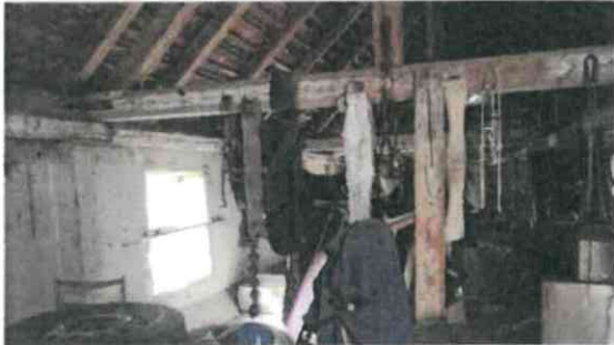
Interiér stavby - nadzemní podlaží
