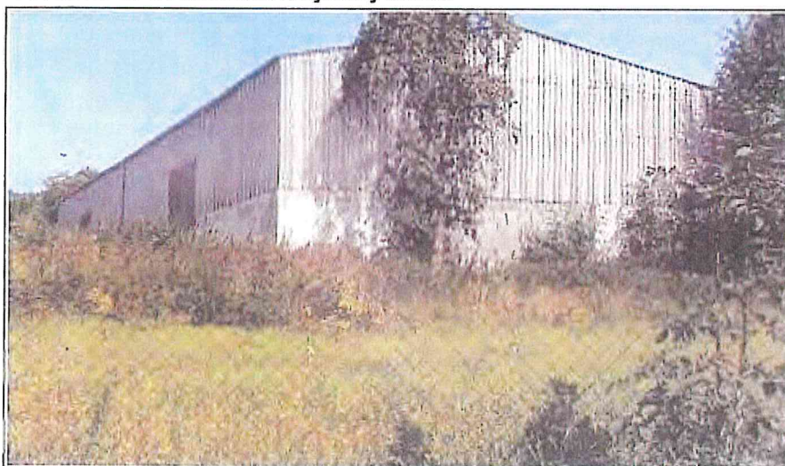
Obrázek 6: Objekt při pohledu od východu
