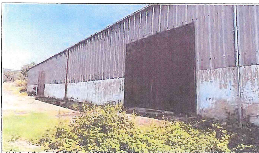
Obrázek 5: Ocelokolna od jihovýchodu
