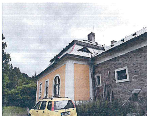
pohled na dům od severozápadu
