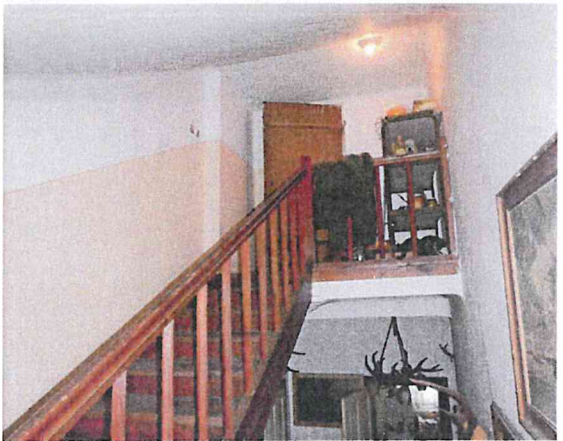
schodiště na půdu
