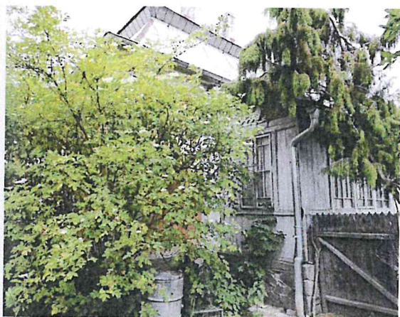
pohled na jihozápadní stranu domu, včetně trvalých porostů
