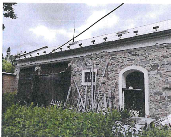
pohled na vedlejší stavbu ze dvora, část zděného plotu
