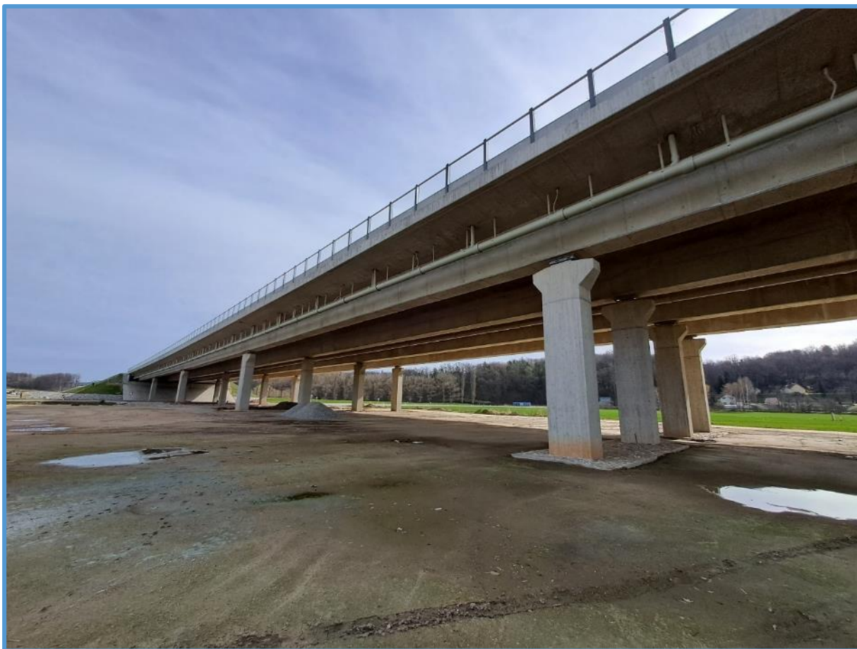
Obrázek 14: Dálnice D3, stavba 0310/II, Hodějovice – Třebonín (foto: Auditní orgán)
