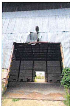
Sklad píce na parc.č. st.1568/1
