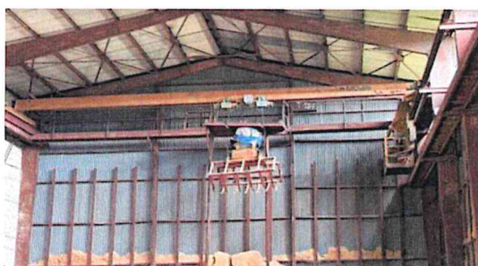
Jeřáb ve skladu píce na parc.č. st.1568/1
