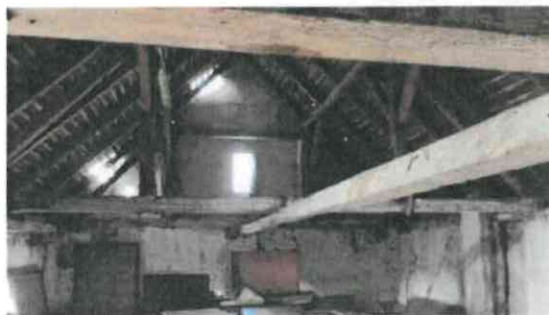
Interiér stavby - nadzemní podlaží
