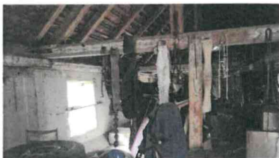
Interiér stavby - nadzemní podlaží
