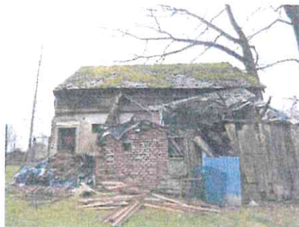
Pohled jižní- přístřešek
