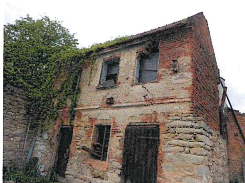
st.93 – stavba bez čp/če pohled jižní
