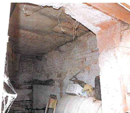
Stavba bez čp/če – interier
