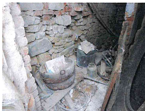
Stavba bez čp/če- interier
