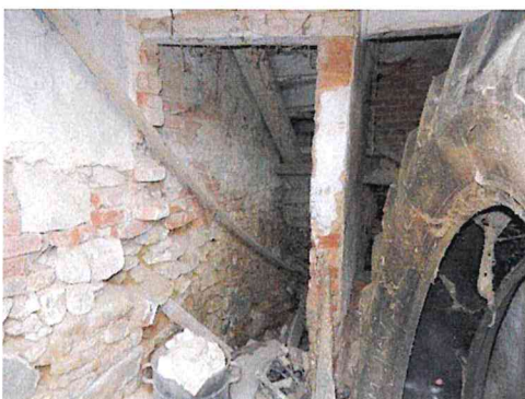
Stavba bez čp/če- interier
