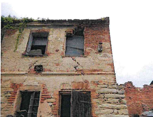
St. 93 – stavba bez čp/če- pohled jižní
