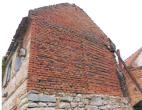
st. 93 – stavba -pohled štít východní
