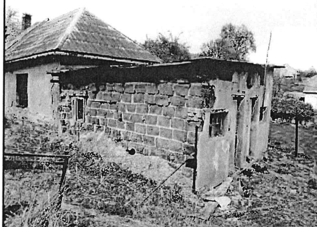
Pouze objekt bez čp/če, na pozemku p.č. St. 216 - pohled S
