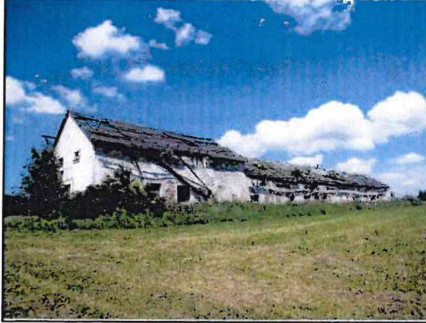
Pozemek p.č. St. 33 včetně objektu - pohled jihovýchodní
